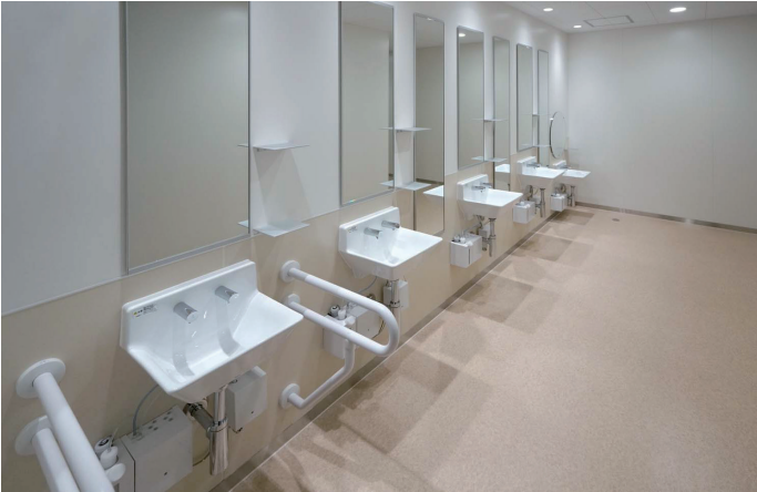
2F女性トイレ 洗面コーナー
