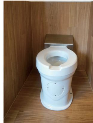
保護室の特性から、洗面はシンプルなカウンターと壁付自動水栓、トイレは水中毒対策および窒息を防止する樹脂・ステンレス製の便器(他社品)を設置。壊されず、紐状の物が引っ掛からない、事故防止設計を徹底した。
