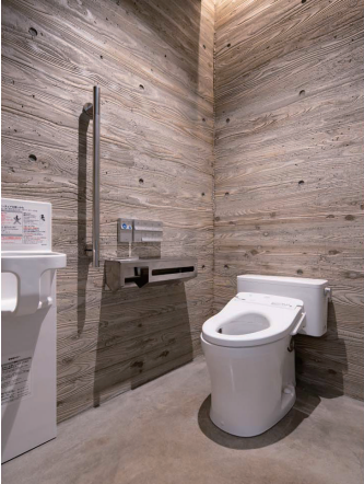
男性トイレ 大便器ブース
