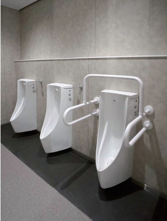
オフィスフロア 男性トイレ 小便器コーナー
