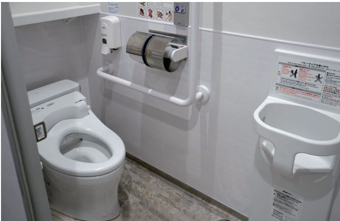
男性トイレ 大便器ブース
