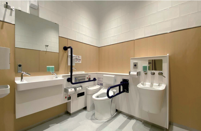
5F多目的トイレ
