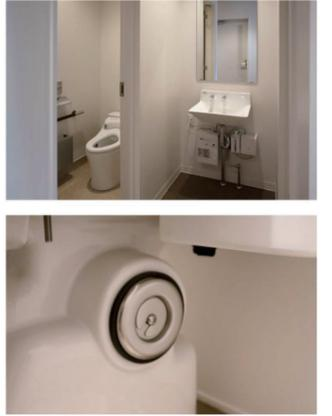
ペットを火葬する方専用の入口側にあるトイレ。男女トイレの間に、自動水栓や自動水石けん供給栓をセットした壁掛洗面器を配置。斎場内すべての大便器は、メンテナンス性に配慮した掃除口付大便器を採用している。
