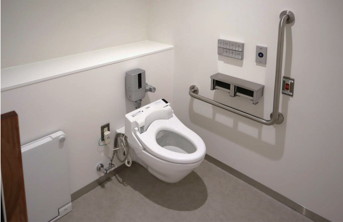
女性トイレ ひろびろブース
