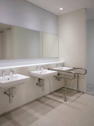
女性トイレ 洗面・ スタイリングコーナー
