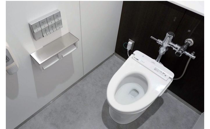
本館4F 女性トイレ 大便器ブース
