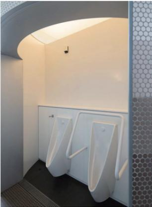
外からの視線に配慮しつつ、通り抜けできる半屋外の小便器コーナー。小便器はマイクロ波センサー壁掛小便器セット、足元には防汚・防臭効果のあるハイドロセラフロアPUを採用。通路の中央に造作の手洗器を設置。
