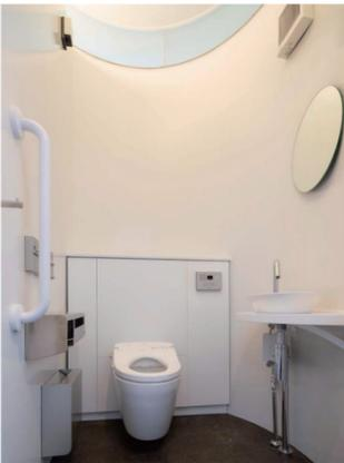
男女トイレ共に、大便器は床の清掃性に優れた壁掛けタイプ、便座は利用者の快適性に配慮してウォシュレットアプリコットPを採用。リモコンはボタンを押すたびに発電するエコリモコンを設置している。
