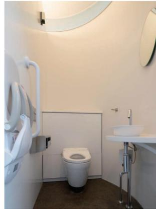
男女トイレ共に、排せつから手洗いまで一連の動作が個室で行える個室完結型。手洗器の水栓は蛇口に触れず衛生的に手洗いができる自動水栓を採用。高齢者や乳幼児連れに配慮して、手すりとベビーチェアを設置。
