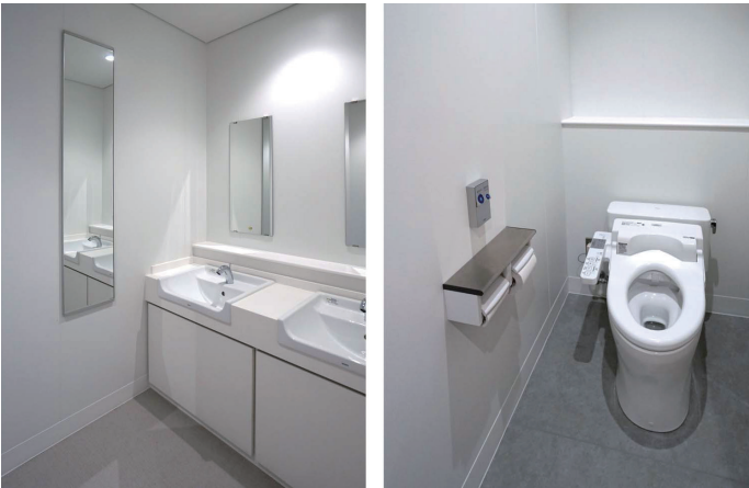
1F 女性職員トイレ 洗面・大便器コーナー
