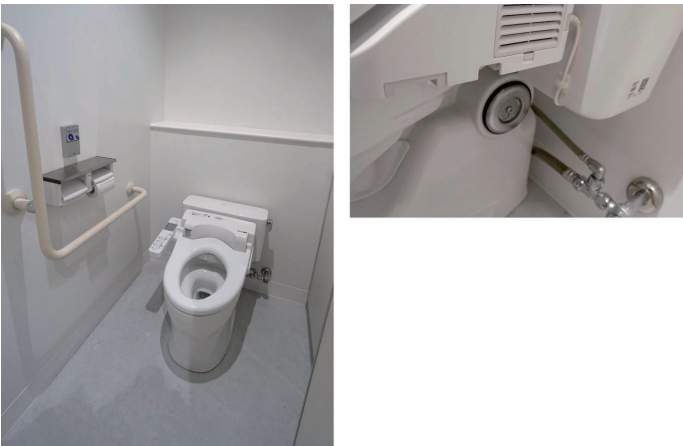
体育館 女性トイレ 大便器ブース
