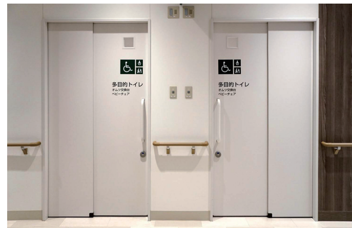
多目的トイレ 入口
