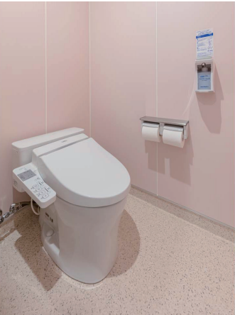
1Fトイレ 前室
