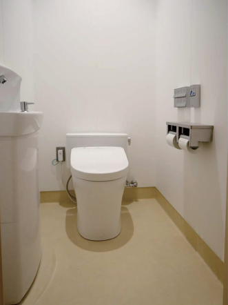
1F保健室 トイレ・シャワー
