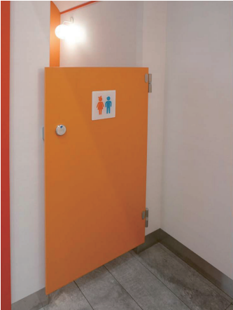
こどもトイレ 大便器コーナー
