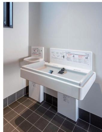
つづら淵の利用者にもトイレを開放しているため、泥汚れに強い床材を採用。壁の立ち上がりまで床材を巻き上げ、隅に埃がたまりにくいように施工。ベビーカーで入れる広さがあり、ベビーシートなどを完備している。
