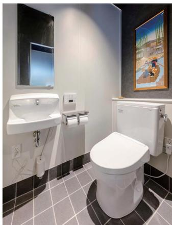
店舗からトイレへの動線には屋根がかり、雨でも濡れずに移動できる。女性トイレでは背中側の奥行きを深く取り、バッグなどを置けるスペースを設置。紙巻器は、小物が置ける棚付二連紙巻器を採用した。
