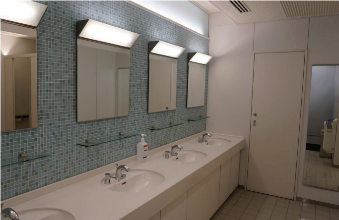
改修前 西側トイレ
