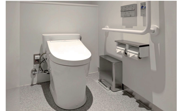
1F 男性トイレ 大便器ブース
