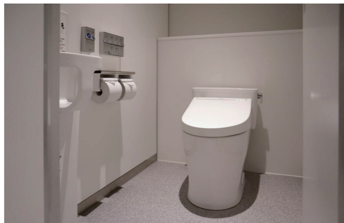
1F 女性トイレ 大便器ブース
