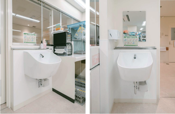
5F病棟 スタッフステーション
