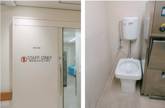
2F病棟 洗浄室
