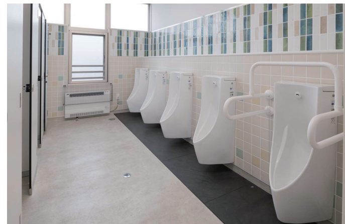
3F南トイレ 小便器コーナー
