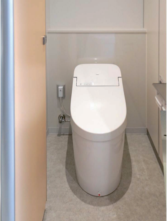
女性トイレ 大便器ブース
