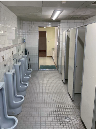
生徒用トイレ 改修前
