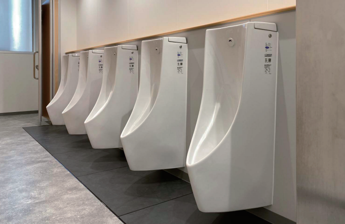
生徒用トイレ 小便器コーナー
