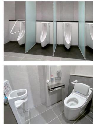
衛生的に手洗いができるよう、自動水栓と水石けん入れを採用。小便器の間には、曇りガラス調の間仕切りを床から天井まで設置することで、プライバシーを確保しつつ、圧迫感のない快適な空間を実現している。
