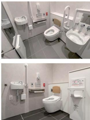
機能分散を図り、オストメイト配慮ブース、乳幼児連れ配慮ブースなど計6ヶ所の手洗器付きの個室を用意。独立した手洗いコーナーも設置され、閉塞感をなくすために部分的にガラス壁を用いている。
