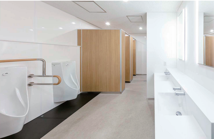
男性トイレ 全体
