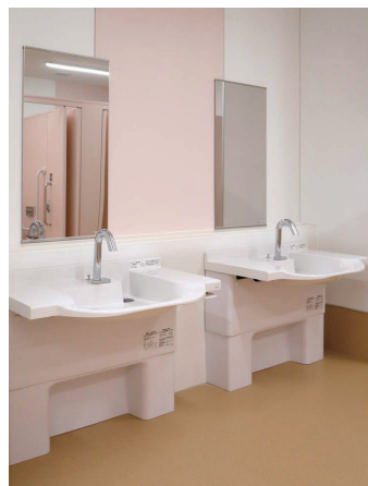
中央棟1F 女子トイレ 洗面コーナー
