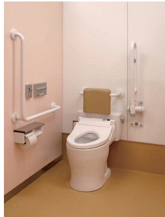
中央棟1F 女子トイレ 大便器ブース④⑤
