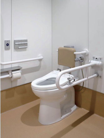
西棟1F バリアフリートイレ
