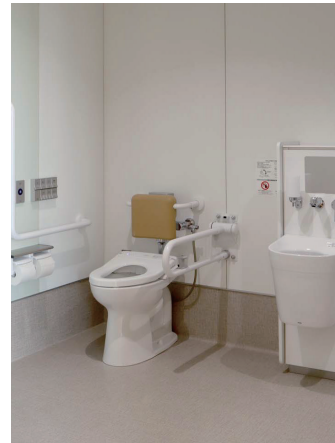
南棟2F バリアフリートイレ
