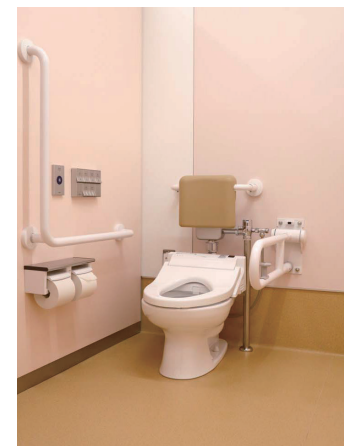
中央棟1F 女子トイレ 大便器ブース②③
