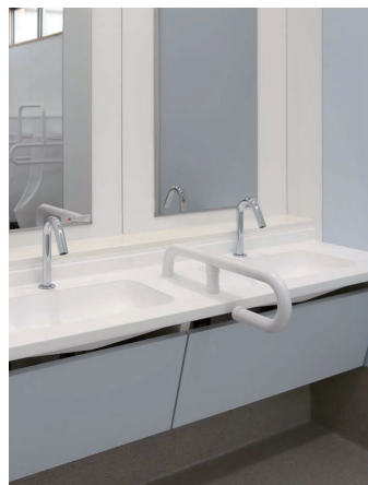
南棟2F 男子トイレ 洗面・小便器コーナー
