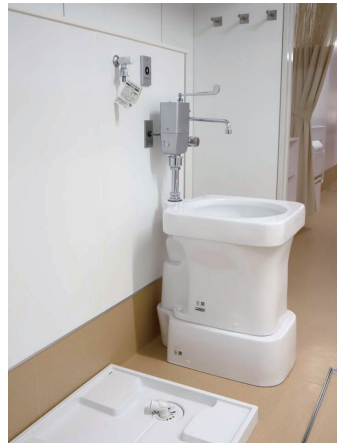
中央棟1F 洗濯・シャワー室
