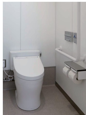
南棟2F 男子トイレ 大便器ブース
