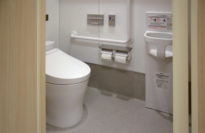
西棟1F 男性トイレ 大便器ブース
