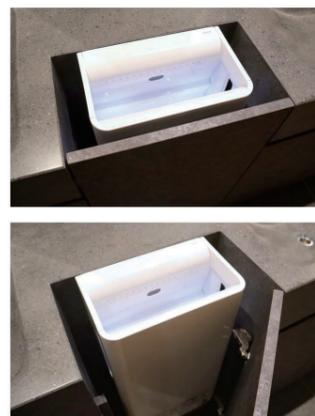
手洗い後の床への水垂れを抑えるため、洗面器の間にクリーンドライ(ハンドドライヤー)を設置。空間の統一感を損なわないようカウンターと同素材で前面を覆っているが、メンテナンスに配慮して扉式としている。
