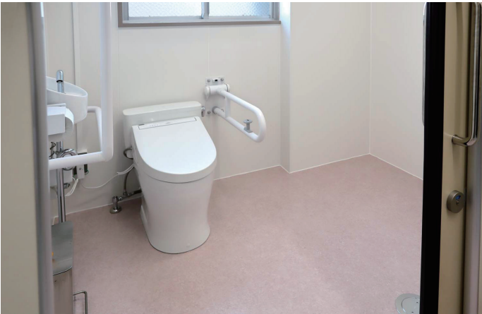
1F 女子トイレ 広めのブース
