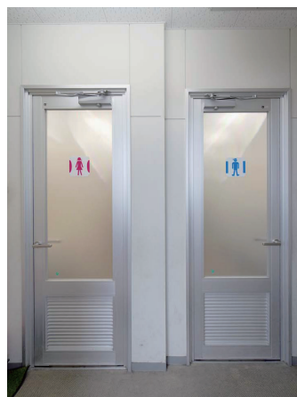
トイレ入口・全体
