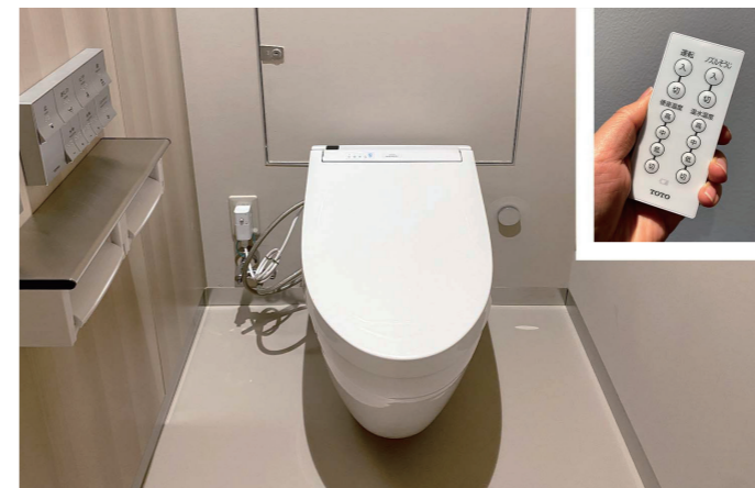
B1Fラウンジ横男性トイレ大便器コーナー
