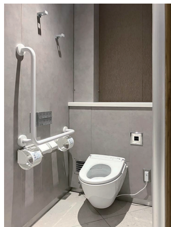
女性トイレ 大便器コーナー
