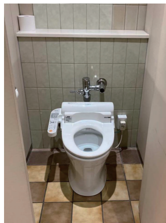
劇場改札内1F 女性トイレ 改修前
